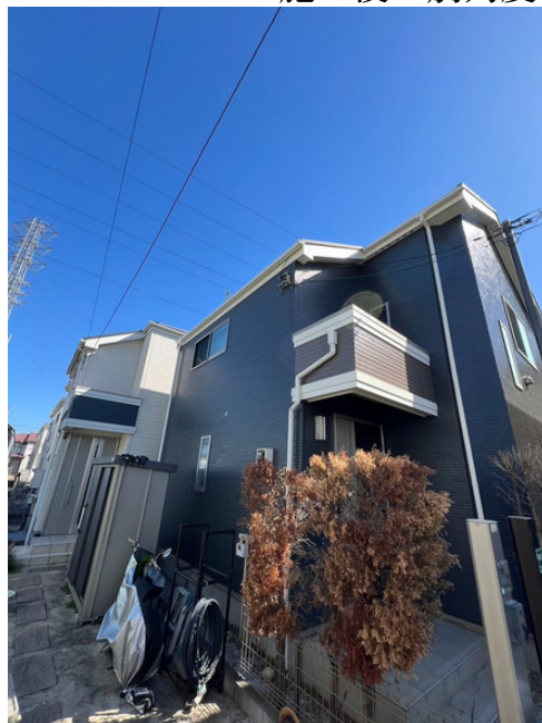
施工後の別角度
