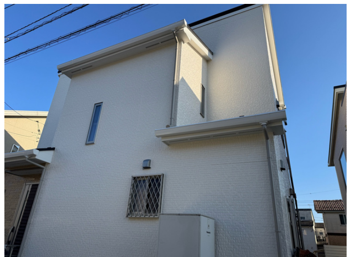
施工後の別角度
