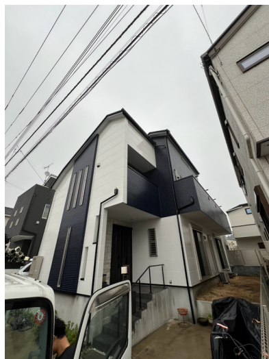
施工後の別角度
