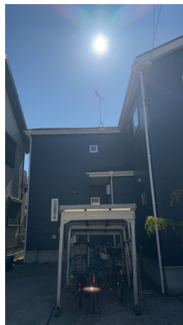
施工後の別角度
