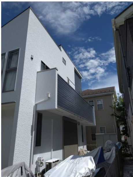
施工後の別角度
