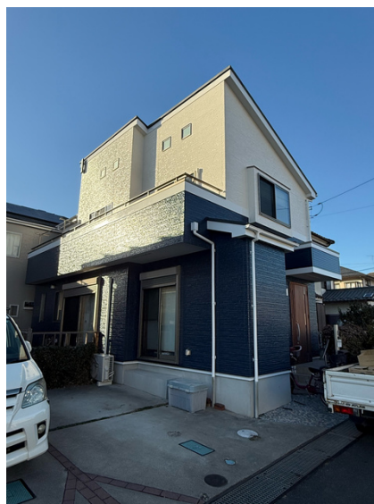
施工後の別角度
