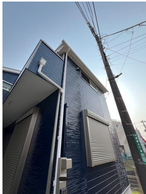
施工後の別角度
