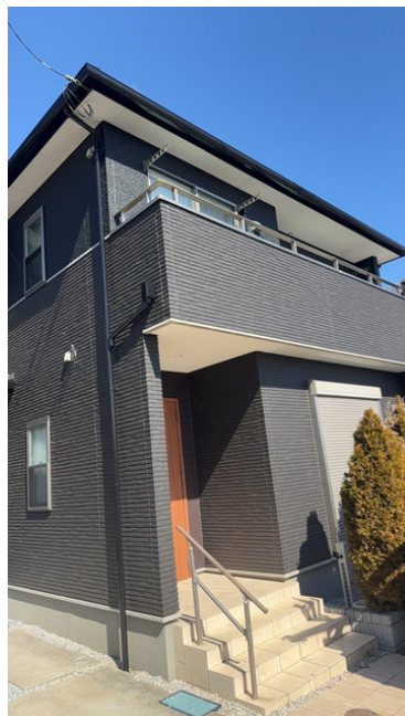
施工後の別角度
