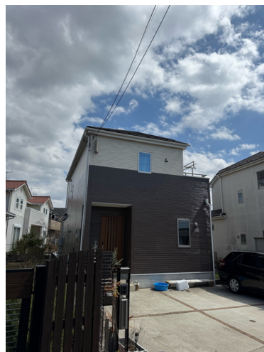
施工後の別角度
