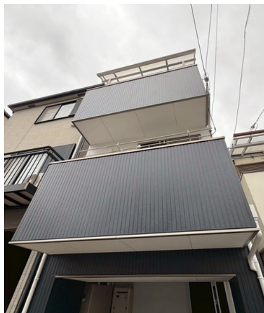
施工後の別角度
