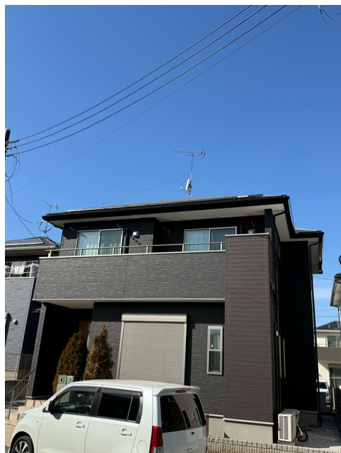
施工後の別角度
