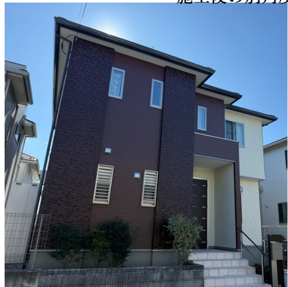
施工後の別角度
