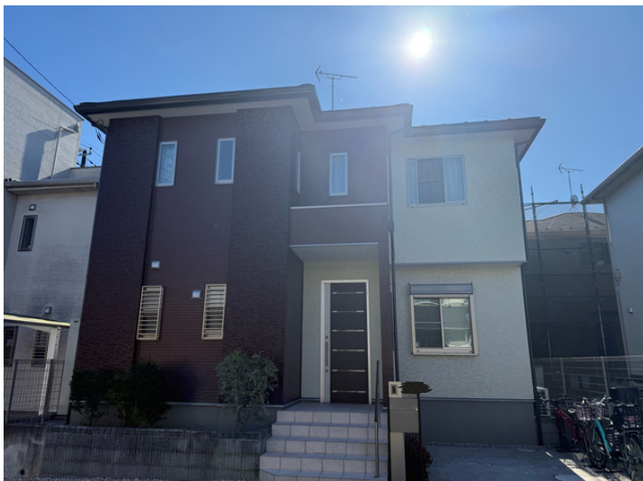
施工後の別角度
